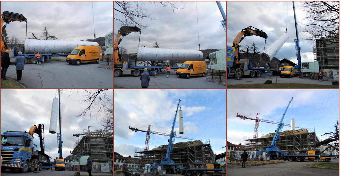
Blick auf die Baustelle am 12.02.20: Einsetzen des Energiespeichers (13,5m lang, 2,2m Durchmesser, 30'000 Liter fassend)
